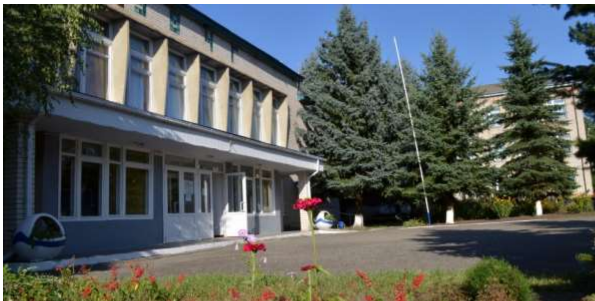
Рисунок 6.1.2. Здание общеобразовательного учреждения ст. Сторожевая 19
