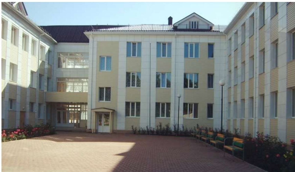
Рисунок 6.1.3. Здание общеобразовательного учреждения ст. Сторожевая 20
